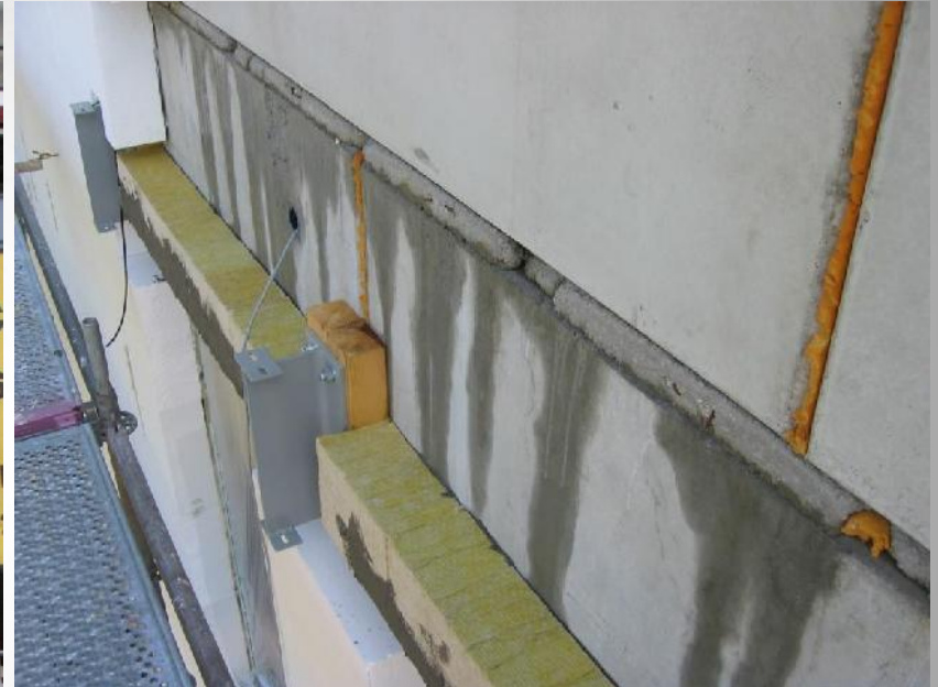
Fehlende Abdichtung – innenliegender Balkon
