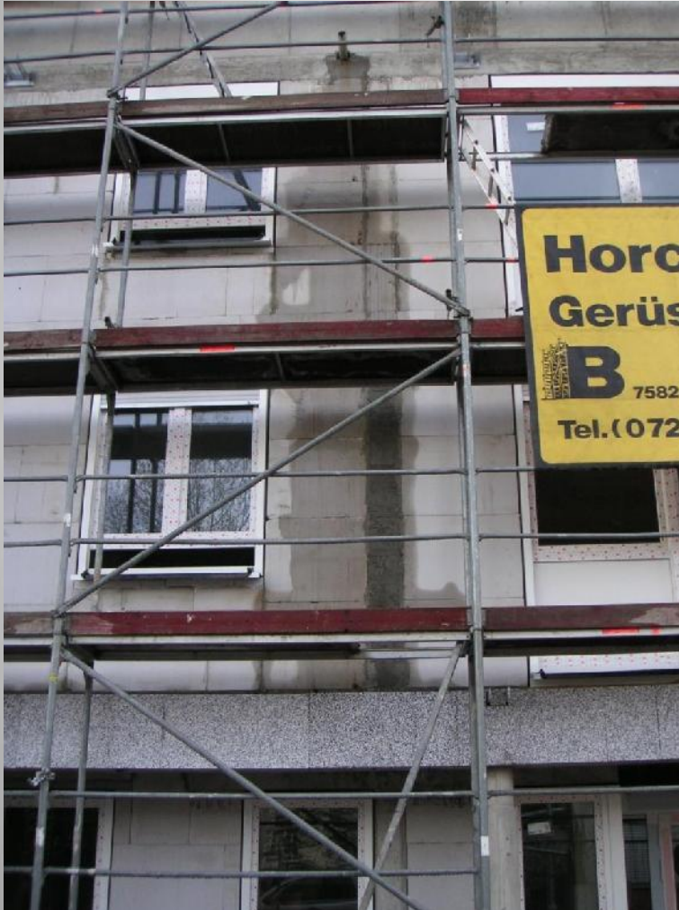
Fehlende Abdichtung – innenliegender Balkon
