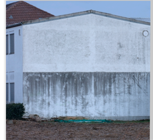
Gebäude mitten in Bühl beim Stadtpark (Südseite)
