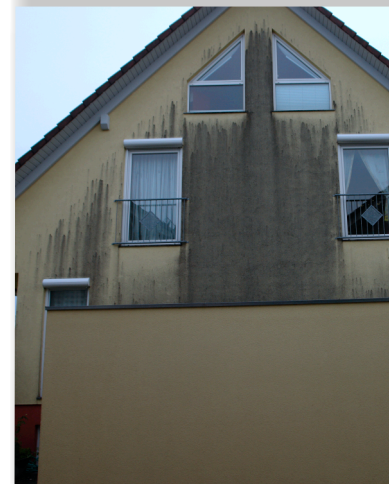
Gebäude 100 m von Asbach entfernt (Südseite)
