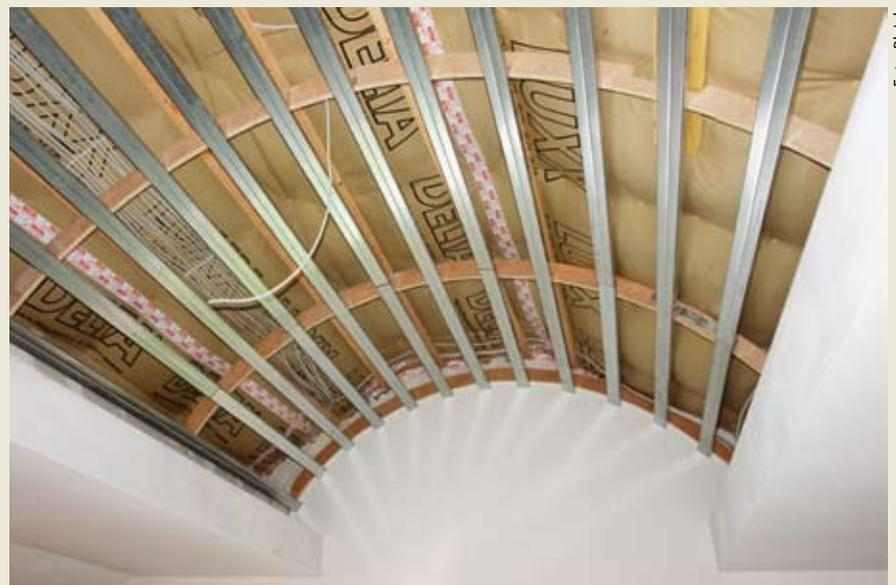
**Tonnengewölbe in Holz.** Wegen der eingeschränkten Höhe über dem Gewölbe hat sich das Ausbaunehmen für eine Ausführung als Holzkonstruktion entschieden. Dazu wurde schichtweise verleimtes Holz verwendet und die Bögen wurden daraus ausgeschnitten.
