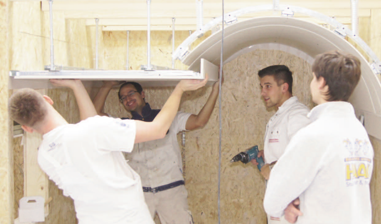
1 Beim Workshop »Trockenbau mit vorelementierten Bauteilen« im Kompetenzzentrum Bühl durften die Seminarteilnehmer mit anpacken. Hier bei der Montage der selbst hergestellten Formkörper auf die zuvor montierte Unterkonstruktion.
