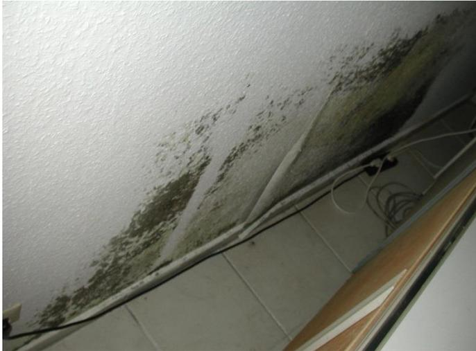
Wenn warme Luft mit relativ hohem Wasserdampfgehalt auf kalte Flächen oder Gegenstände trifft, wird diese Luft abgekühlt. Das Wasser-Aufnahmevermögen der Luft sinkt
